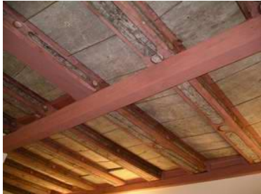
Decke im Foyer
