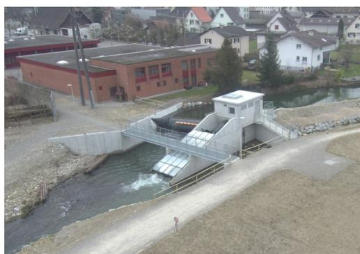
Zur Verbesserung der Fischgängigkeit in der Suhre wurde neben dem Kleinwasserkraftwerk eine Fischaufstiegshilfe erstellt. Der Fischabstieg erfolgt durch die spezielle Wasserkraftschnecke in der Anlage. Mit diesen Massnahmen wurde zusätzlich auch die Suhre als Gewässer ökologisch aufgewertet.
